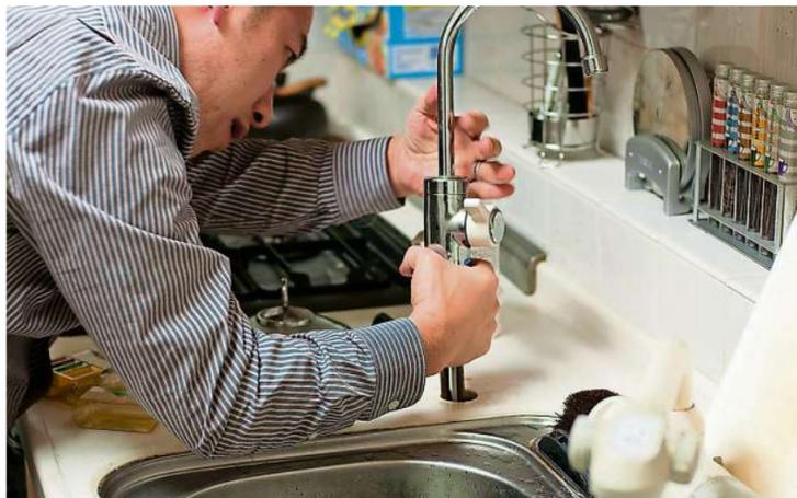
Sanitärinstallateur oder die Sanitärinstallateurin schliessen beispielsweise die sanitären Apparate und Armaturen an. Fotos: zvg
