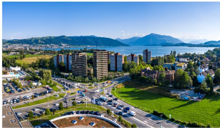
Ab 2027 führt die UCH nach dem Knoten Alpenblick in Cham via den neu zu erstellenden Knoten Duggeli durch den Tunnel Städtlerwald direkt nach Cham.
