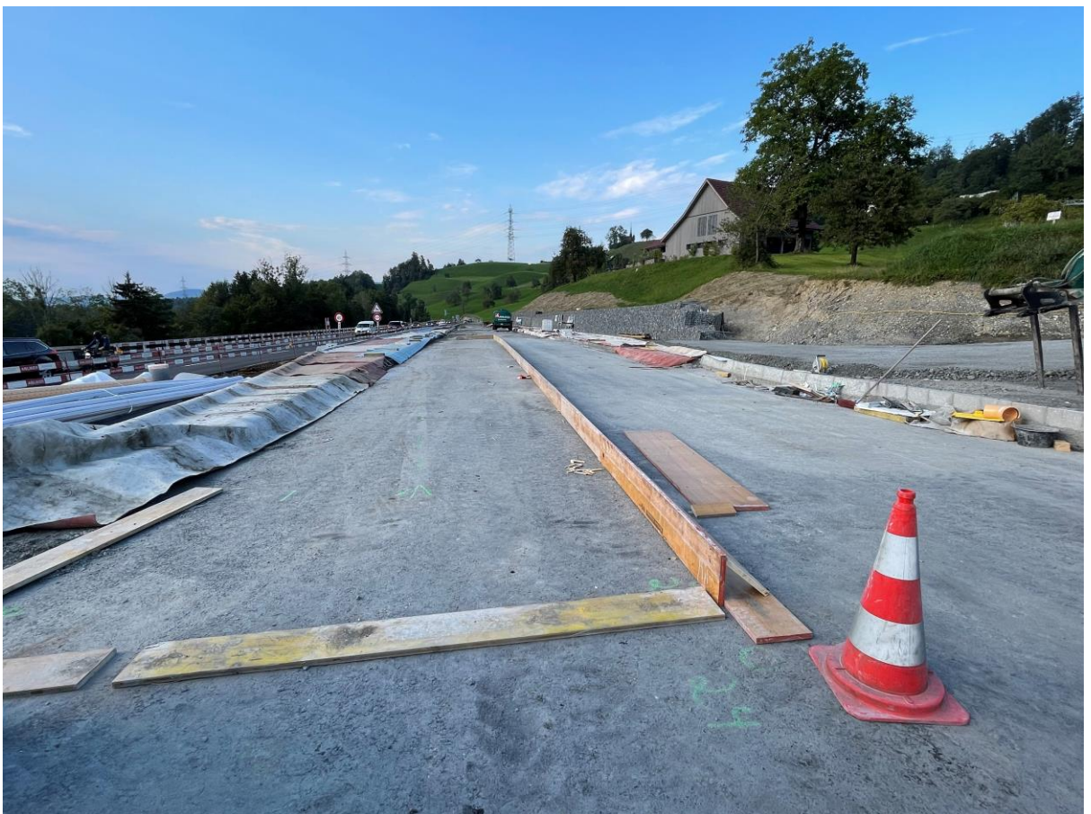
Die Arbeiten beim Knoten Nidfuren sind weit fortgeschritten.
