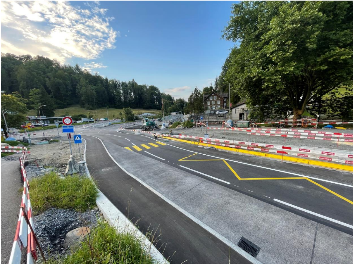
Beim Knoten Schmittli werden nächste Woche diverse Deckbeläge eingebaut, was zu Verkehrsbehinderungen führt.
