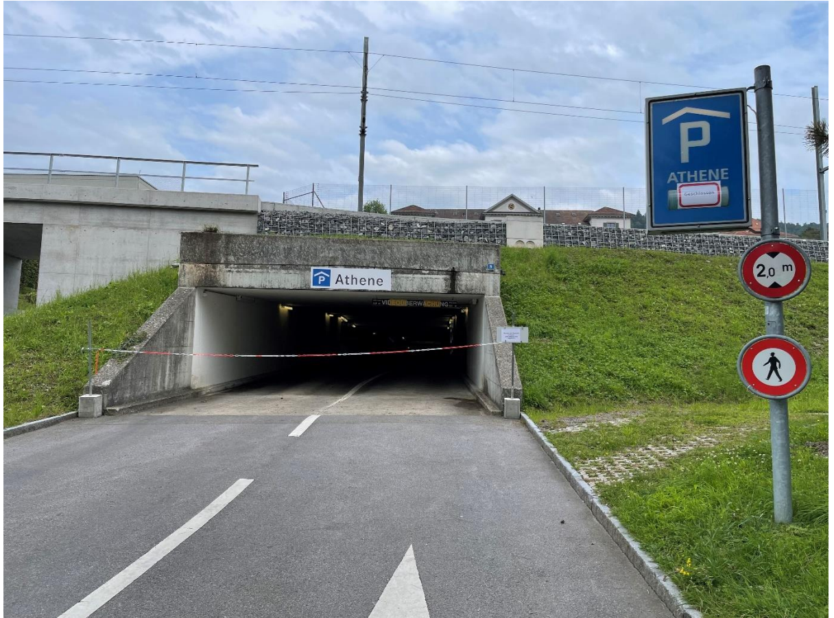
Das Parkhaus Athene im Quartier St. Micheal in Zug wird saniert und ist darum ab sofort geschlossen.
