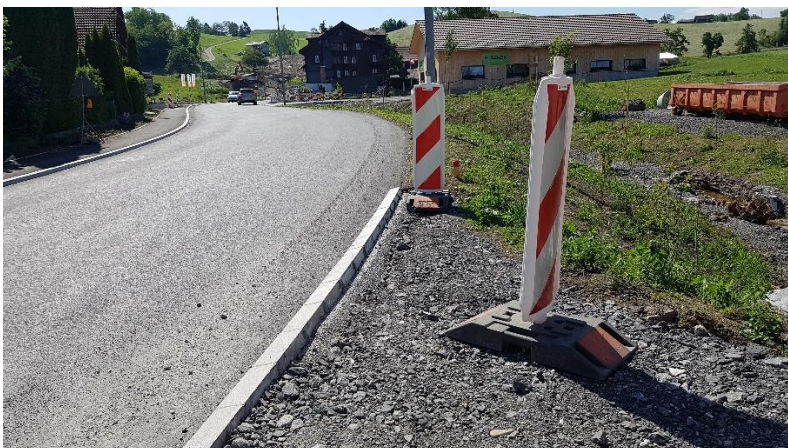
Noch fehlt der Hinterburgstrasse der neue Deckbelag.
