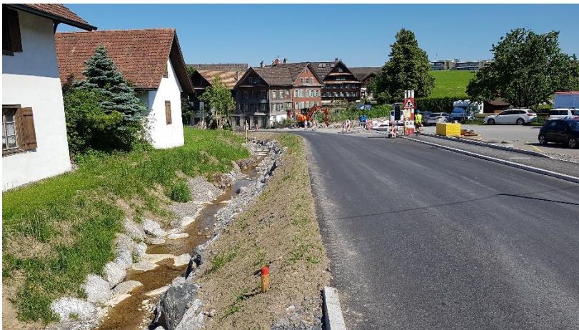
Der Hinterburgmühlbach fliesst in einem neuen Bett.
