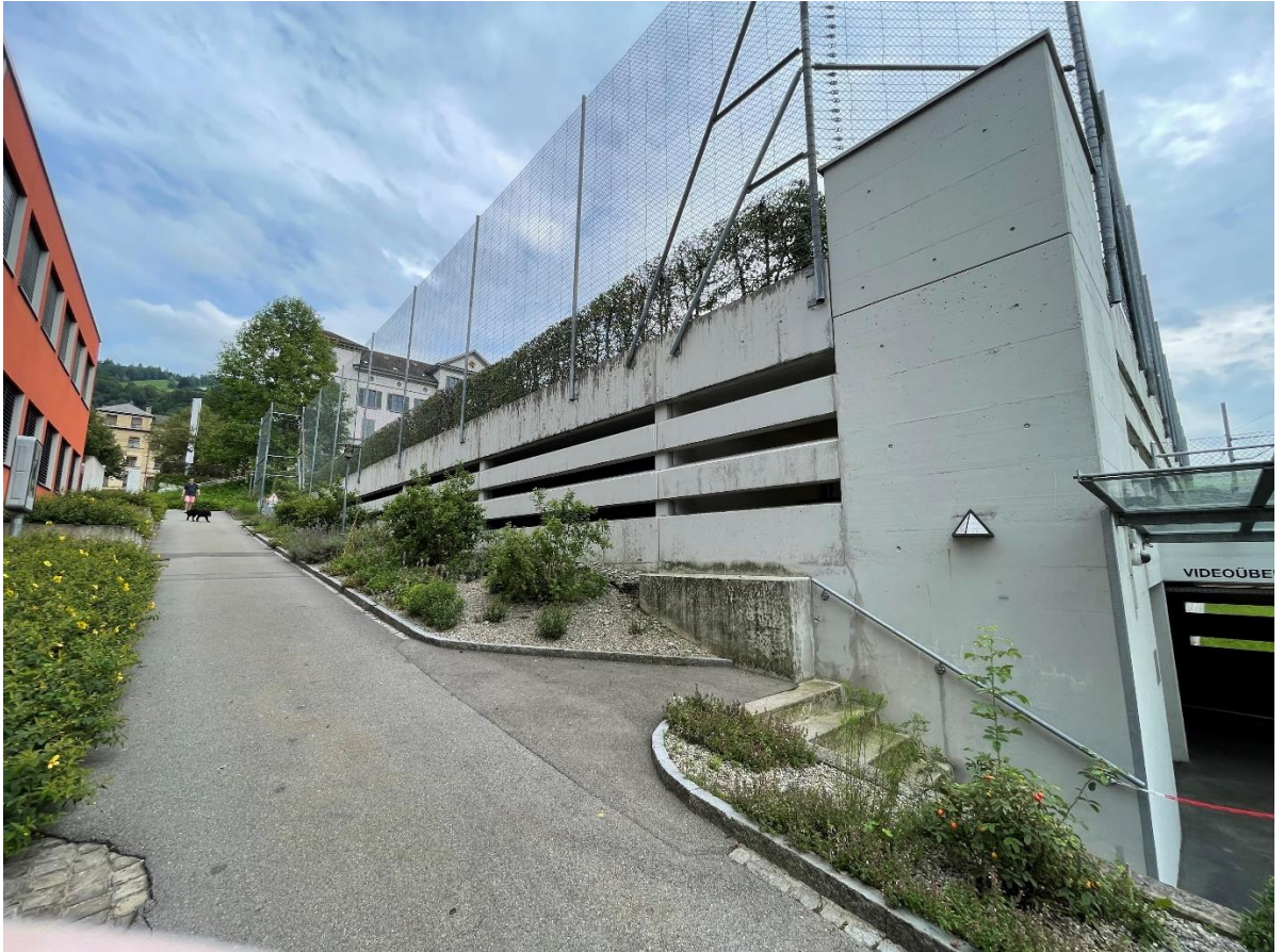
Die Sanierung des Parkhauses Athene im Quartier St. Micheal in Zug steht kurz vor Abschluss.
