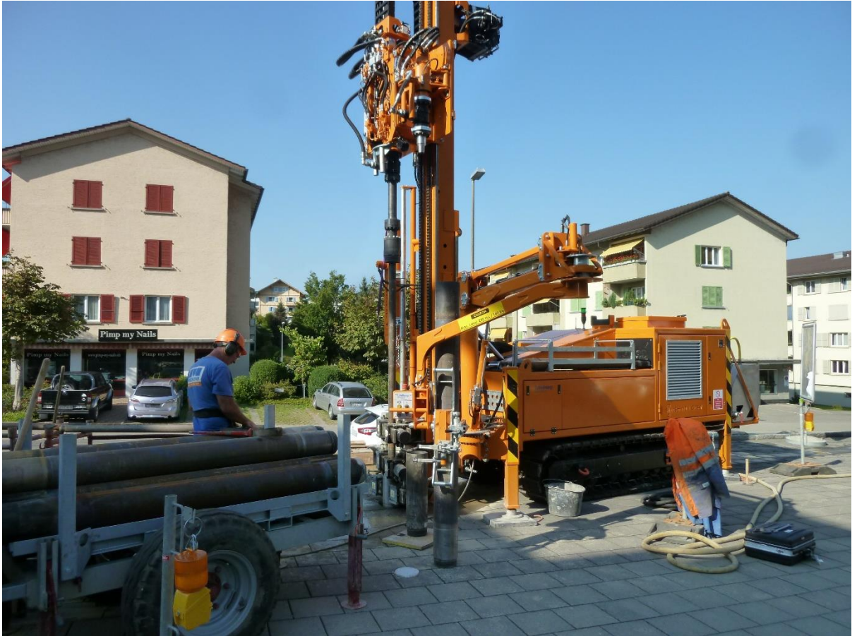
Mittels Kernbohrungen können geologische Grundlagen ermittelt werden.
