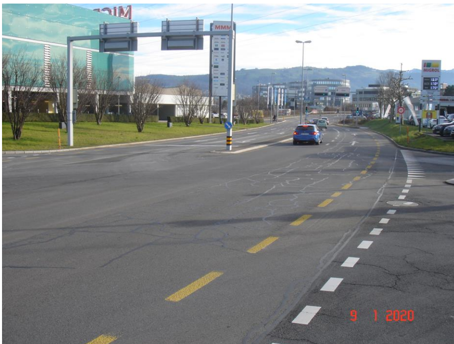
Die Hinterbergstrasse Steinhausen auf der Höhe der Einfahrt zum Strassenverkehrsamt des Kantons Zug.
