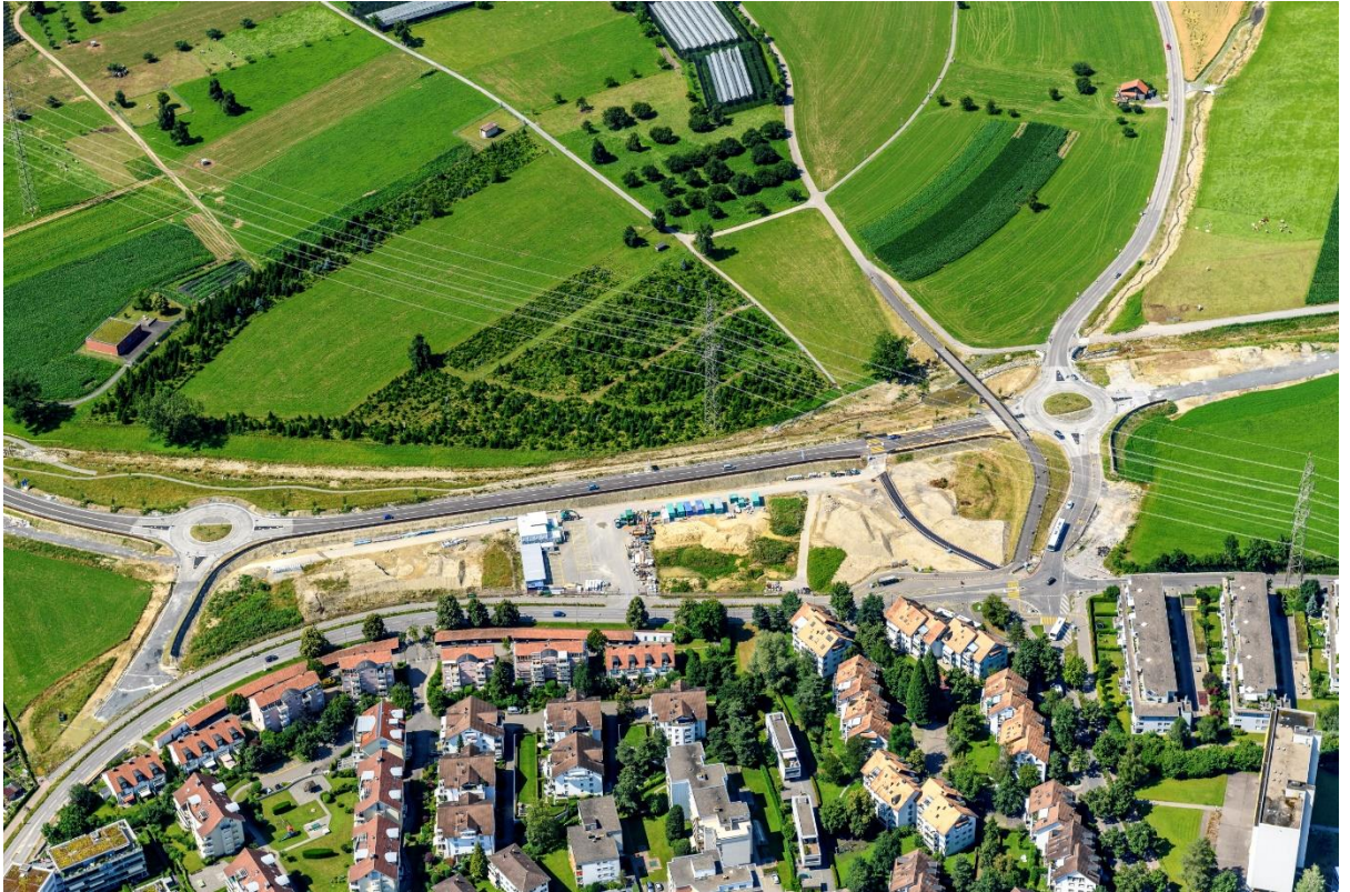
Auf den im Bild ersichtlichen Abschnitten der Inwilerried- und der Rigistrasse in Inwil werden ab Montag, 19. April 2021, die Deckbeläge eingebaut.
